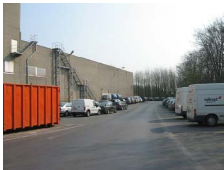
Foto 10: parkeerruimte tussen gebouw en N203a
