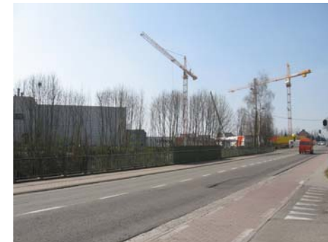
Foto 2: Edingensesteenweg (N7) richting Lembeek
